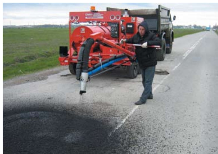
Установка MAGNUM в работе
