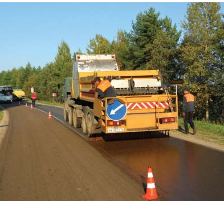
Нанесение пропитки CRF
