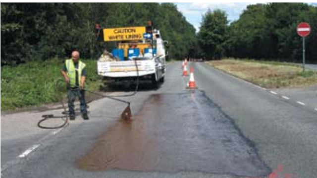
Ручное нанесения состава CRF®
