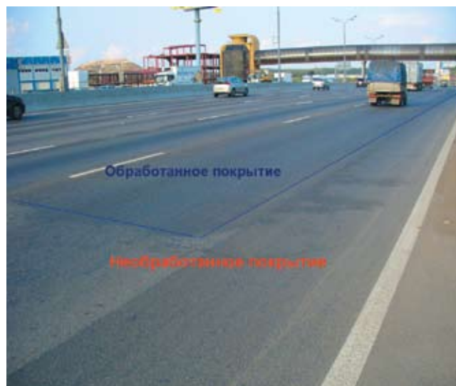
Опытные работы в России. Москва, МКАД, 77-78 км. Спустя сутки после нанесения Reclamite
