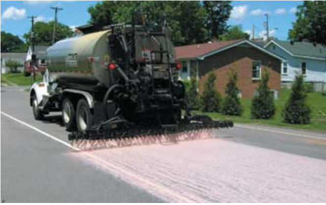
Нанесение пропитывающего состава Reclamite® автогудронатором
