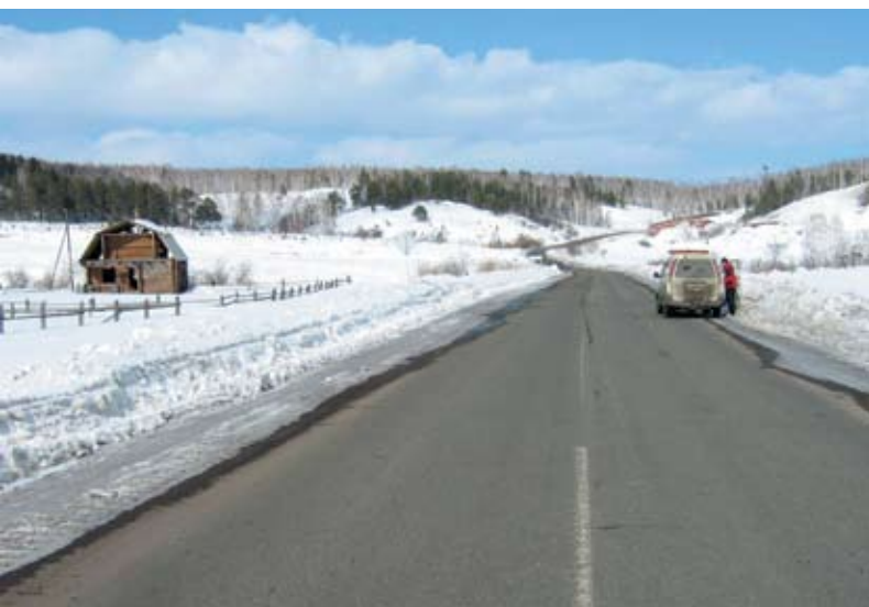
Отчетливо видна разметка, выполненная с подгрунтовкой Reclamite
