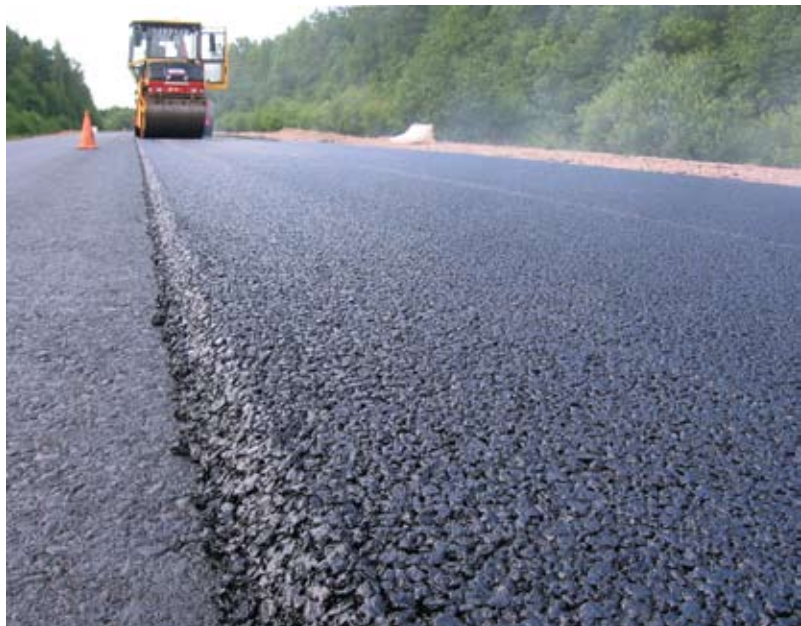
Уплотнение дорожного полотна, содержащего Genicel (Германия)
