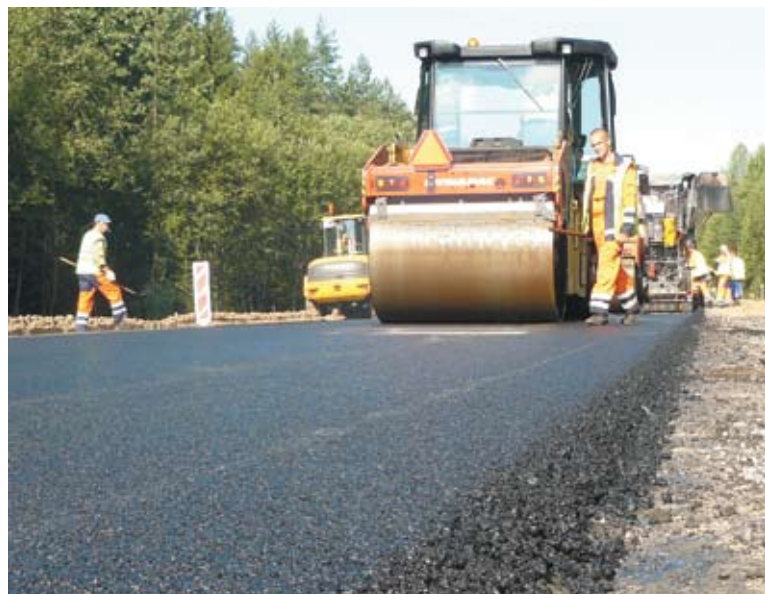
Опытный участок с применением Forta (работает ЗАО «ВАД»)
