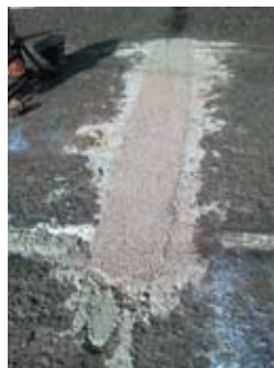
TechCrete на трассе А-114 «Вологда – Новая Ладога» (работы выполнены ДЭП-186)
