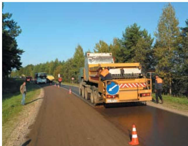
Нанесение пропитывающего состава CRF в районе города Углич
