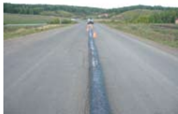
Нанесение Reclamite в качестве подгрунтовки перед нанесением разметки 8 сентября 2009 г.
