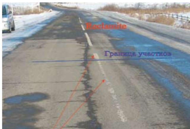
Участок нанесения Reclamite Участок без нанесения Reclamite
