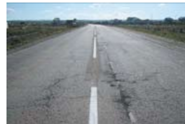
Нанесение осевой линии разметки км 9+000 – км 10+000 9 сентября 2009 г.
